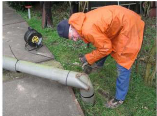
Boven: de lichtmast staat nog. Rechts boven: en nu ligt hij. Rechts: de geknikte mast wordt afgeslepen. Foto's Jan Huisman
