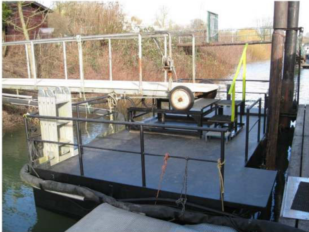
De ponton op zijn plaats, met de loopbrug op de nieuwe oplegging De brug rijdt van laag tot hoog water 90 cm heen en weer. (Foto Jan Huisman)
