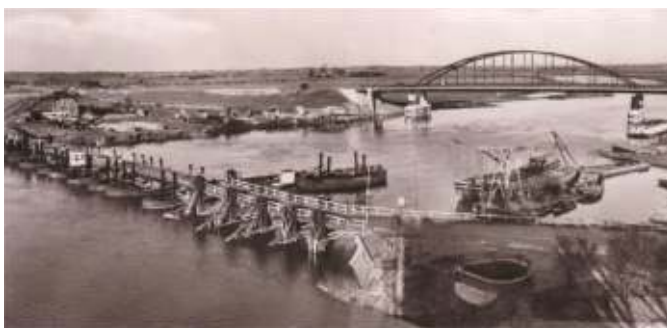
De schipbrug bij Doesburg
