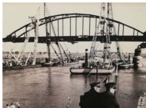
Het inhijzen van de brug met 4 bokken
