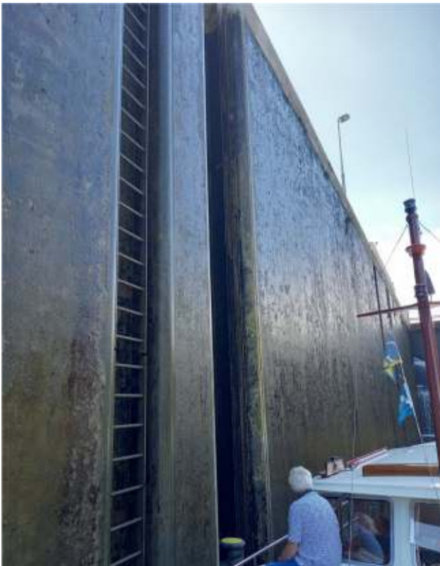
Sluis Lanaye, verval 17 meter!
