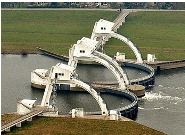
Stuw Driel is de kraan waarmee Rijkswaterstaat de waterverdeling tussen IJssel en Nederrijn/Lek kan regelen
